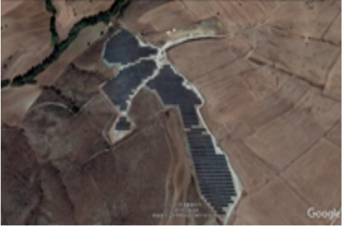
*Eskişehir Santral Görüntüsü
