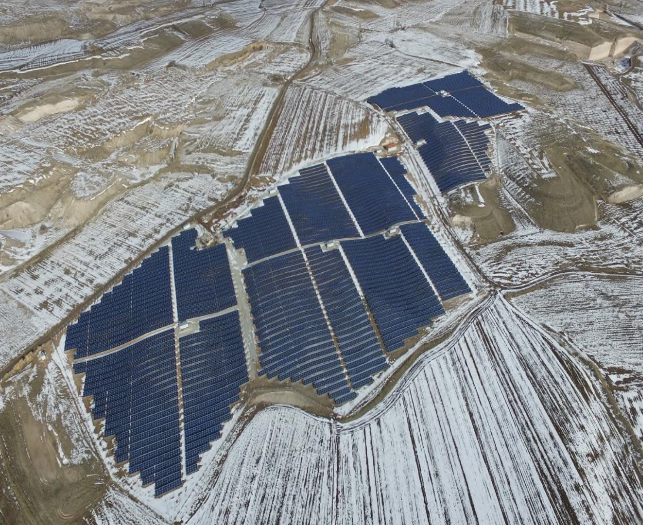
* Nevşehir Santral Görüntüsü
